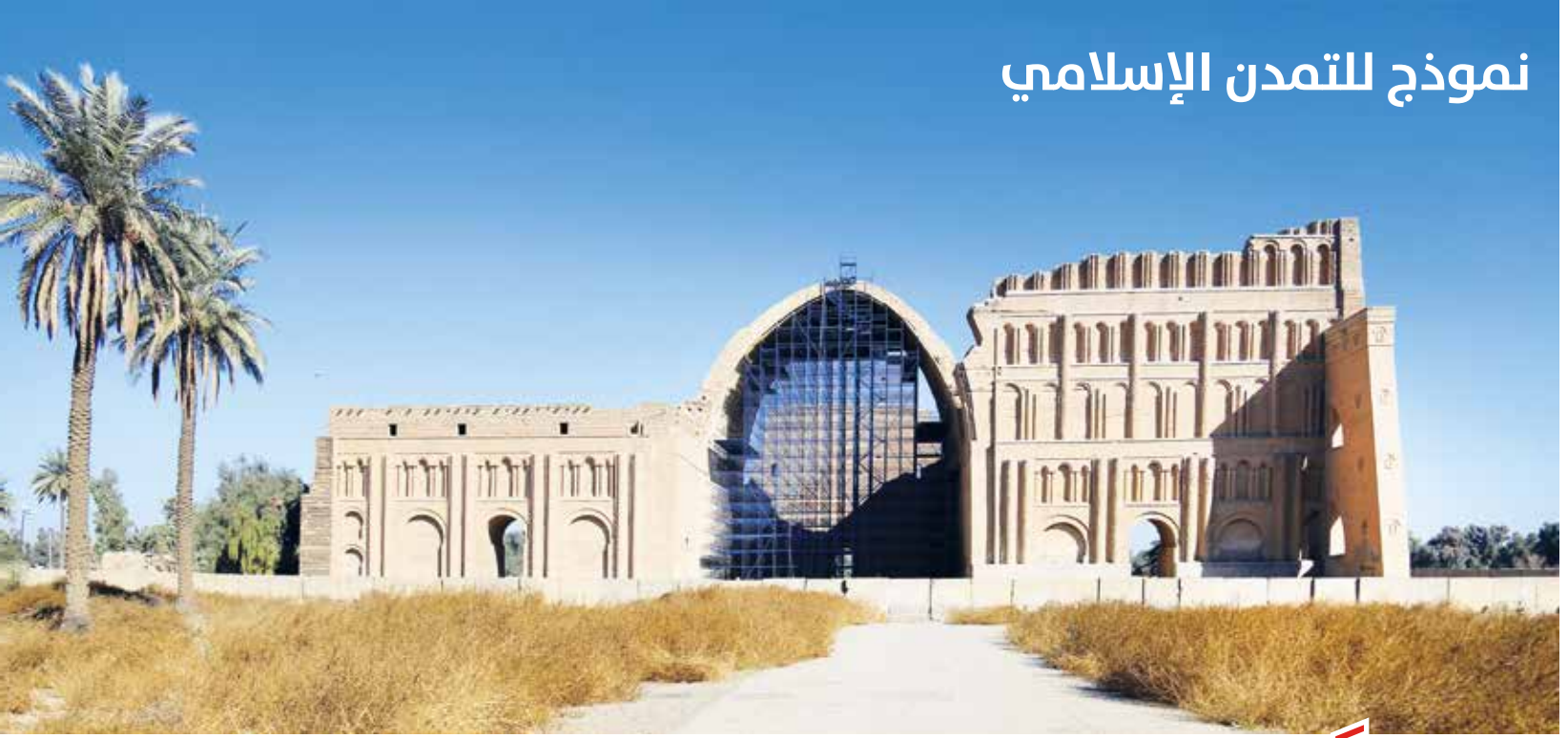
طاق كسرى، الواجهة الشرقية.
